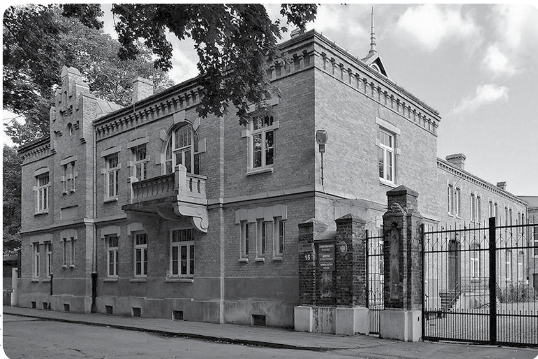
Budynek Miejskich Zakładów Sanitarnych przy ul. Spokojnej, obecnie mieści się tu Wydział Sztuki Mediów ASP
