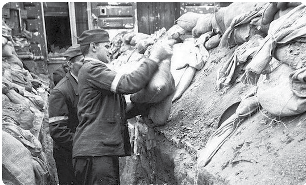
Szybko porządkowano rozwalisko, układano następne worki, wzmacniano konstrukcję
